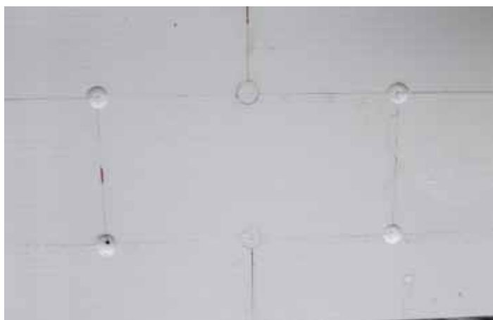
Pravilno fiksirana termoizolaciona ploča / 1
