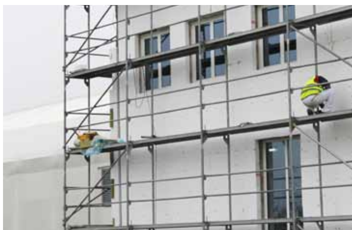
Pravilno fiksirana strana zgrade tiplovima
