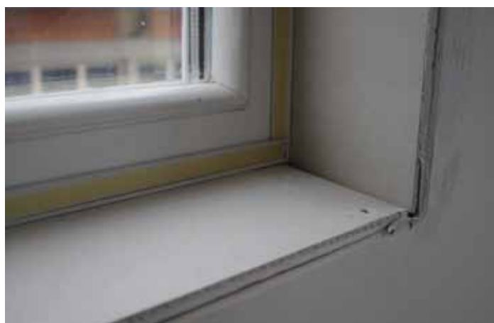
Ugradnja kontakt lajsne 9mm na okvir prozora sa obradom gips pločama
