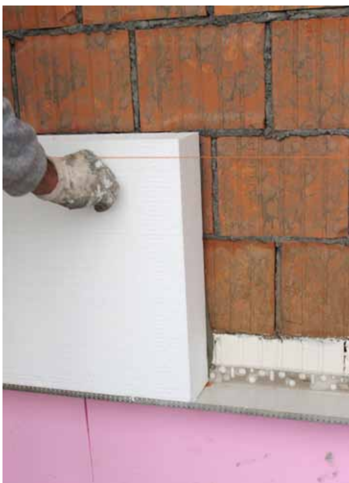
Ugradnja stiropora na profil
